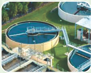
Effluent Treatment Plant (ETP) Zero Liquid Discharge (ZLD)
